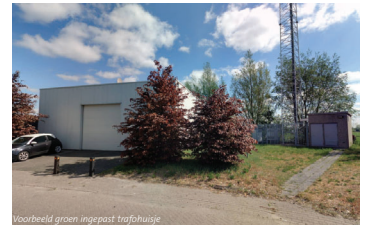
Voorbeeld groen ingepast trafobuise
