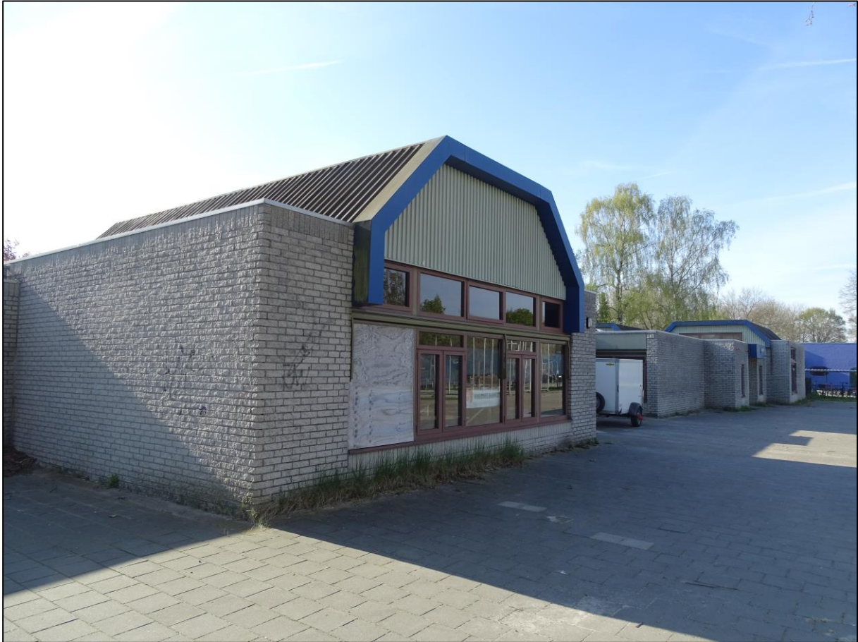
Figuur 1.2 Westzijde van het schoolgebouw, gezien vanuit het noordwesten.
