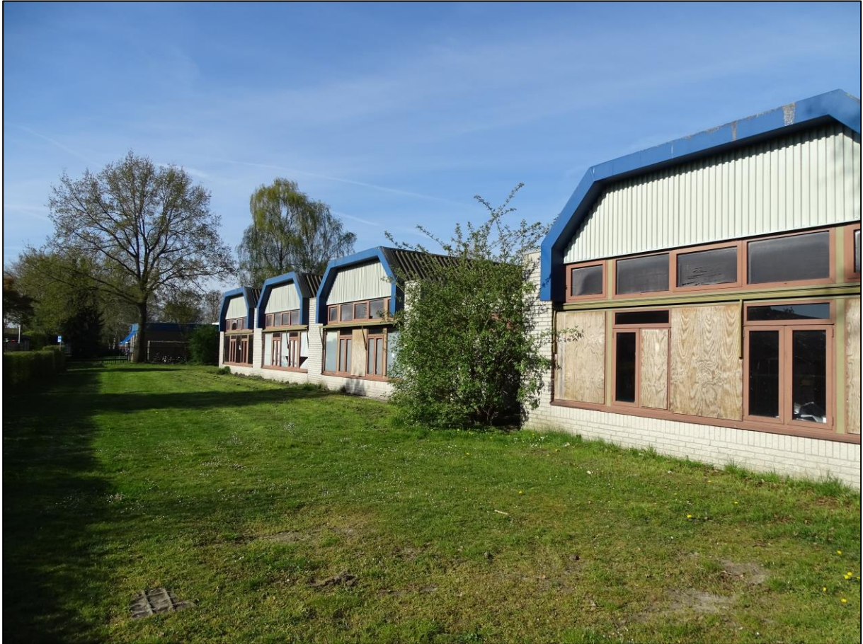
Figuur 1.4 Achterzijde van het schoolgebouw, gezien vanuit het oosten.
