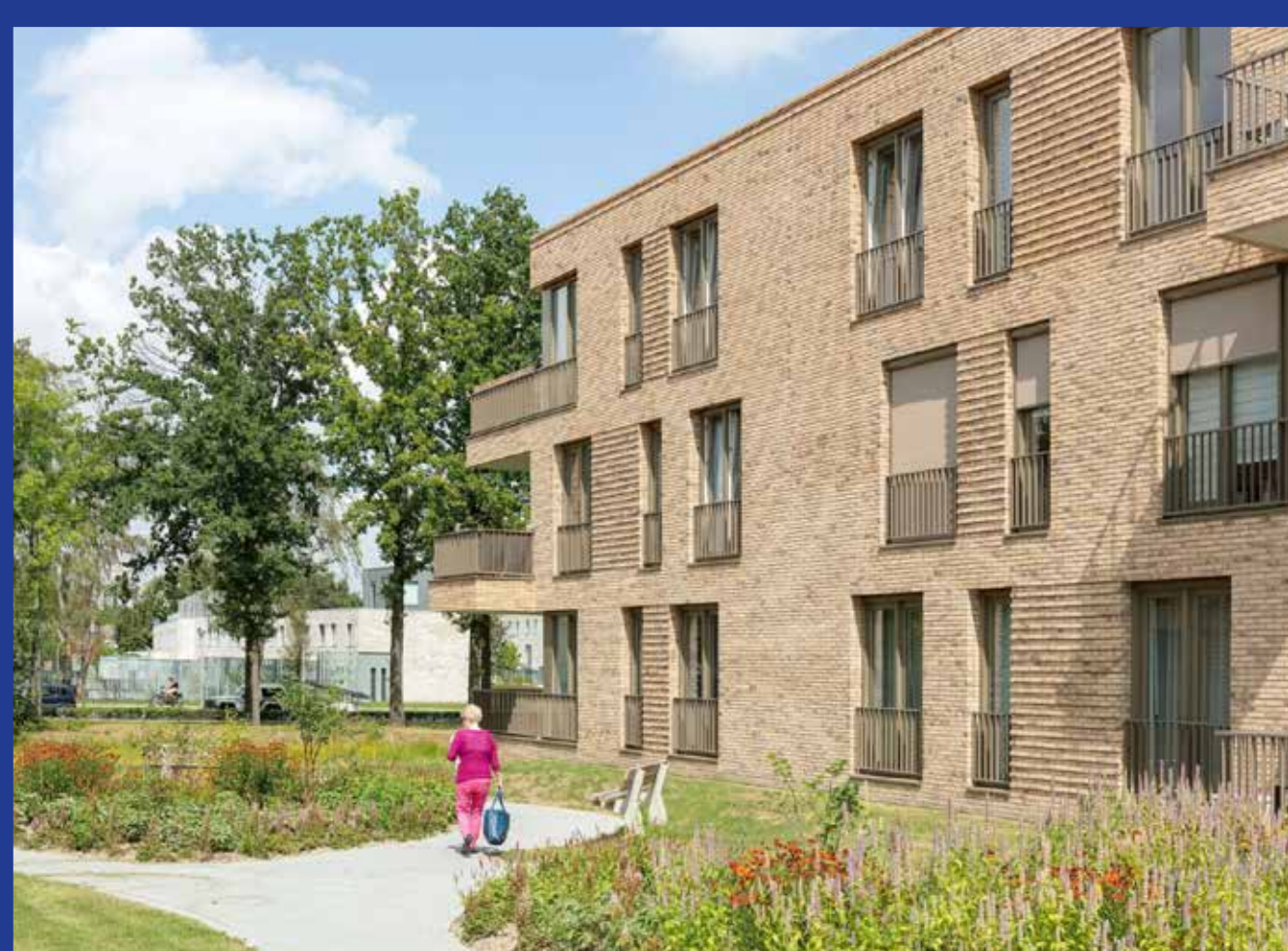
Appartementen, senioren, voorbeeld in Etten-Leur
