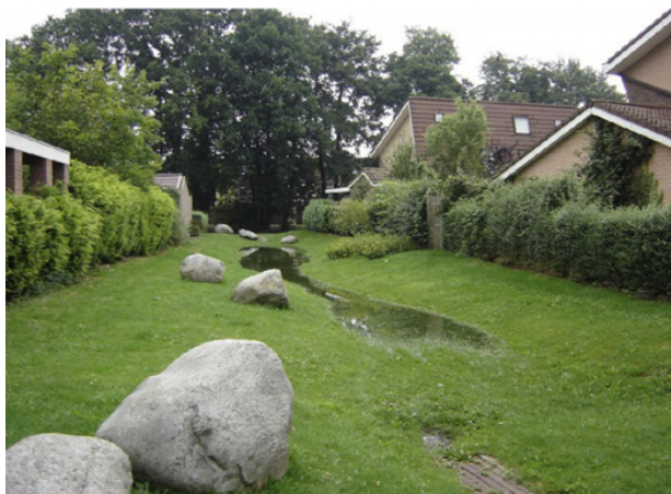
Afbeelding: Wateropvangreservoir (Wadi) in een woonwijk
