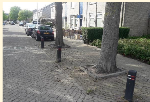
Bomen met onvoldoende ondergrondse groeiruimte (Zwartsluis, Lijnbaan)
