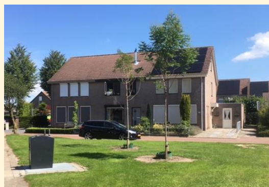
Boom op goede afstand voor zonnepanelen op het dak (Genemuiden, Greente)
