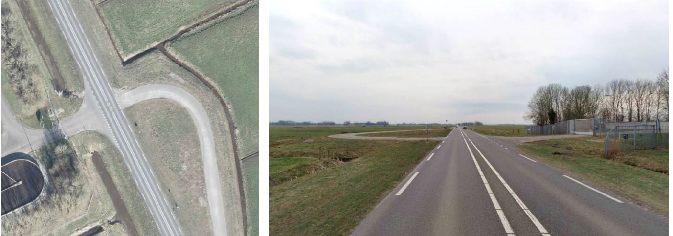
Foto 2-10: Ontsluiting rioolwaterzuiveringsinstallatie op N759 (bron: Globespotter)
