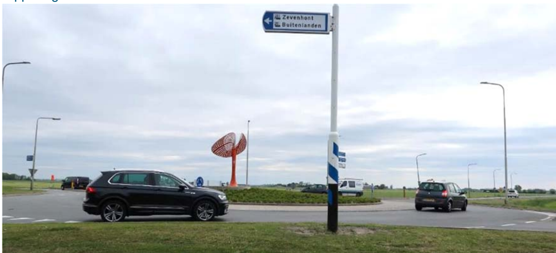
Foto 1-1: Rotonde N759 – Nijverheidsstraat – Provinciale Weg - Randweg
