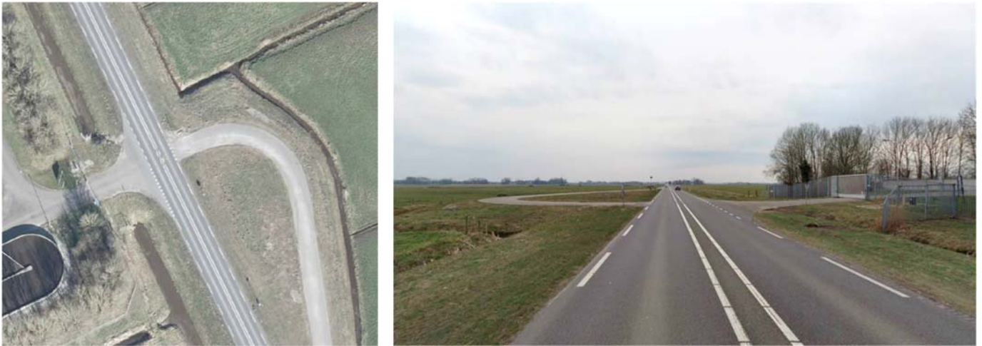
Foto 2-10: Ontsluiting rioolwaterzuiveringsinstallatie op N759 (bron: Globespotter)
